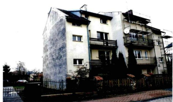
Widok budynku od strony ulicy Różanej
